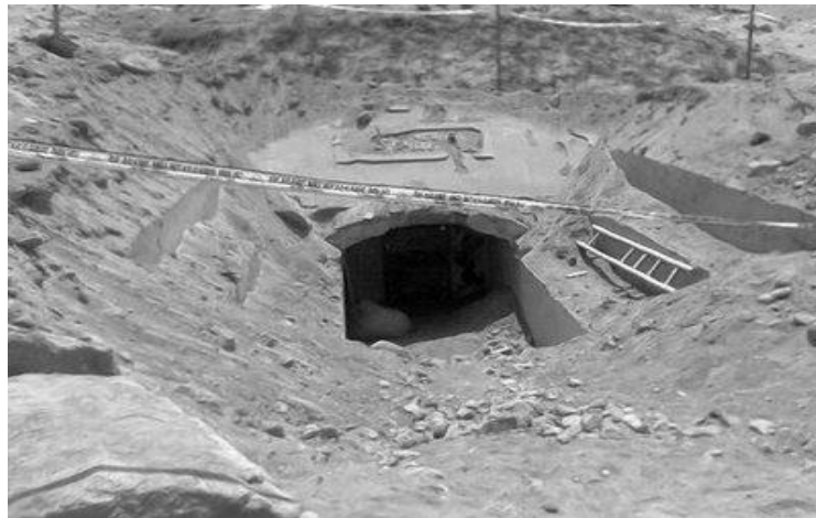
Gambar 2. Bunker yang Berada di Kali Adem yang Rusak Saat Erupsi Merapi Tahun 2006
